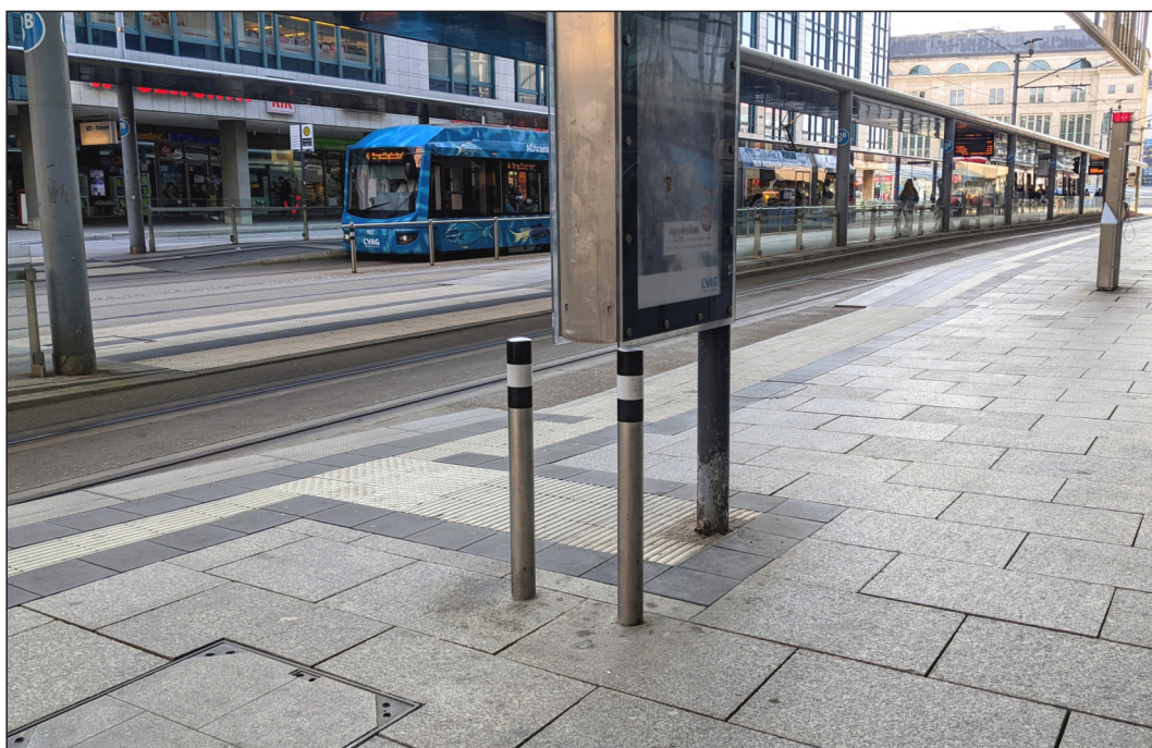
Abbildung 6: Unterlaufschutz (Chemnitz, Zentralhaltestelle)
