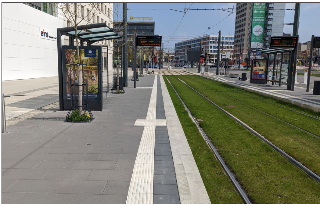
Abbildung 21: Straßenbahnhaltestelle „Stefan-Heym-Platz“, Chemnitz mit guter Erkennbarkeit des Einstiegsfeldes durch Überhang
