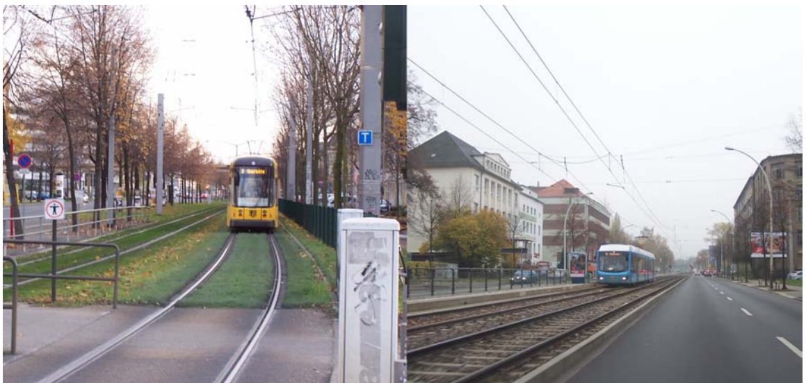
Foto: Vergleich Rasengleis in Dresden mit Schottergleis in Chemnitz
