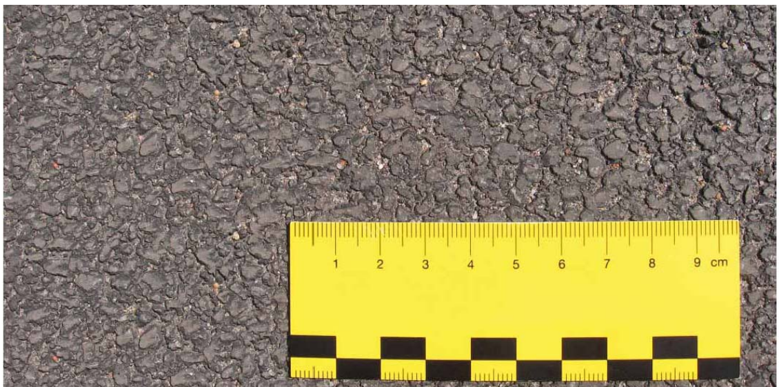
Durch eine verringerte Grobtextur der Asphaltoberfläche lassen sich die Geräuschemissionen im Straßenverkehr vermindern. Der speziell für die Stadt Düsseldorf entwickelte Asphalt besitzt daher ein Größtkorn von nur 5 mm.
