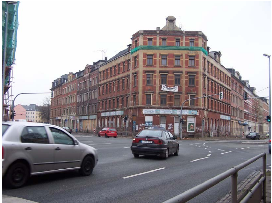
Foto: gefährdeter Eckbereich Müllerstraße/Mühlenstraße
