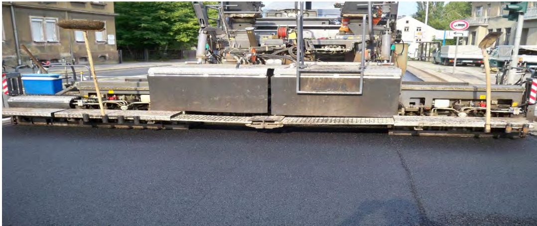
Foto: Einbau LOA 5C in der Zwickauer Straße
