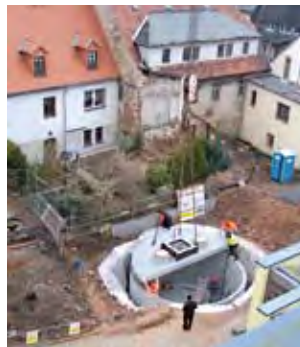
Montage des Pelletlagers – Peletti wartet schon
