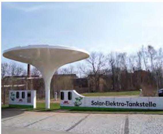
Solar-Elektro-Tankstelle mit 25 Solarzellen
