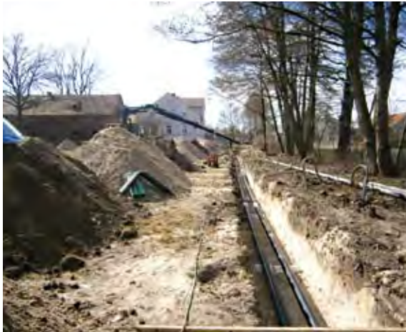
Bau der Nahwärmetrasse für die Dorfheizung
