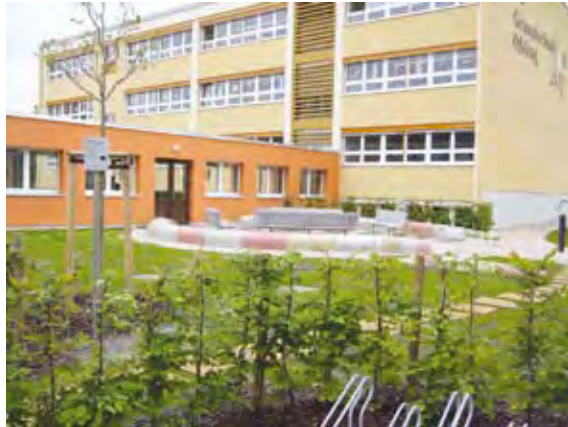
Sanierung Grundschule Oßling
