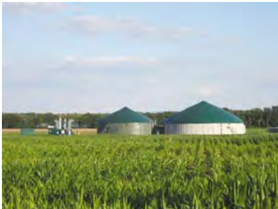
Biogasanlage der Gemeinde Oßling
