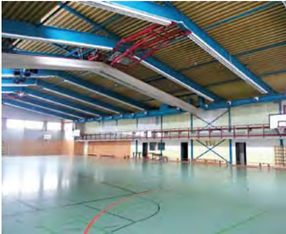
Innenansicht der Mehrzweckhalle
