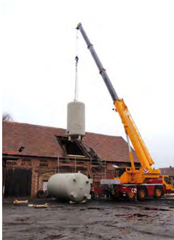
Einbau des Pufferspeichers
