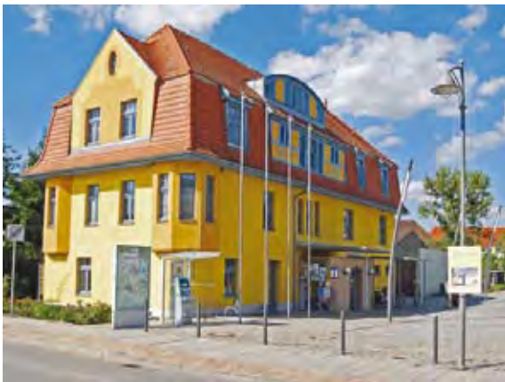
Stadthaus mit Fernwärmeanschluss
