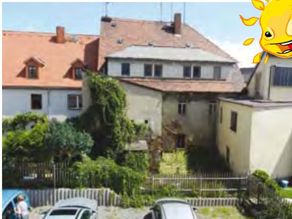
Schulgasse 4 – künftige Energiezentrale mit Solarinchen
