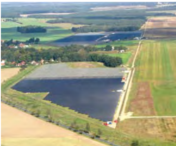
PV-Anlage auf dem Flugfeld
