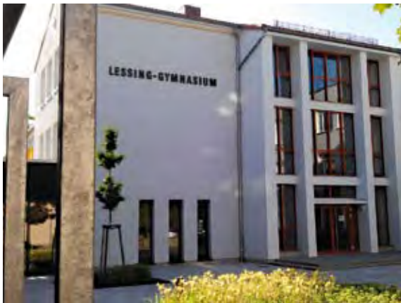
Ansicht des Lessing-Gymnasiums
