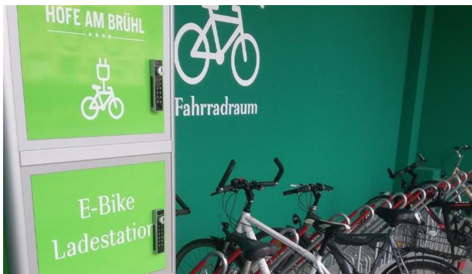
Foto: Schließfächer zum Laden von Pedelec-Akkus im Fahrradraum der „Höfe am Brühl“, Leipzig
