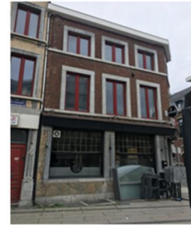
D. Guter Zustand, aber leerstehend
