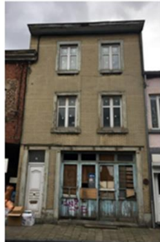
B. stark sanierungsbedürftig
