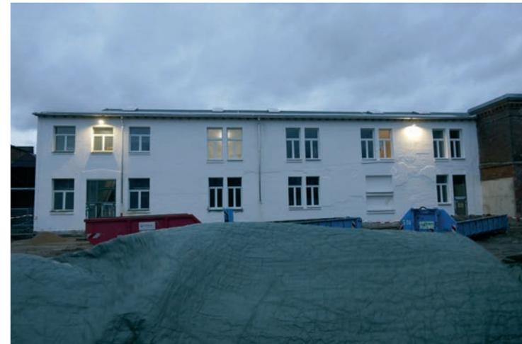
Südfassade in der Dämmerung: die Beleuchtung am Gebäude ist bereits erneuert, für die Eingänge ausreichend, für die Beleuchtung der Platzfläche sind andere oder zusätzliche Leuchten erforderlich
