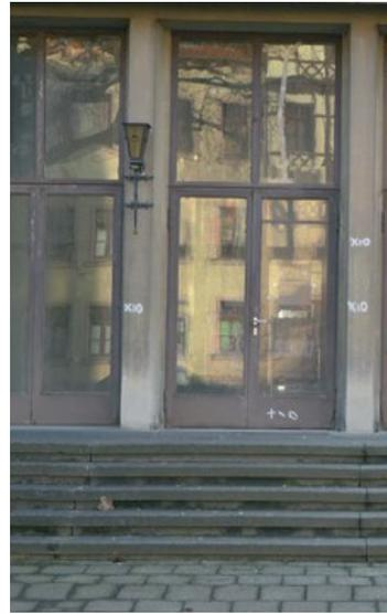
Beleuchtung Türbereich Eingang 1A – kann mit neuer Beleuchtung entfallen, Positionierung kann für neue Beleuchtung aufgenommen werden
