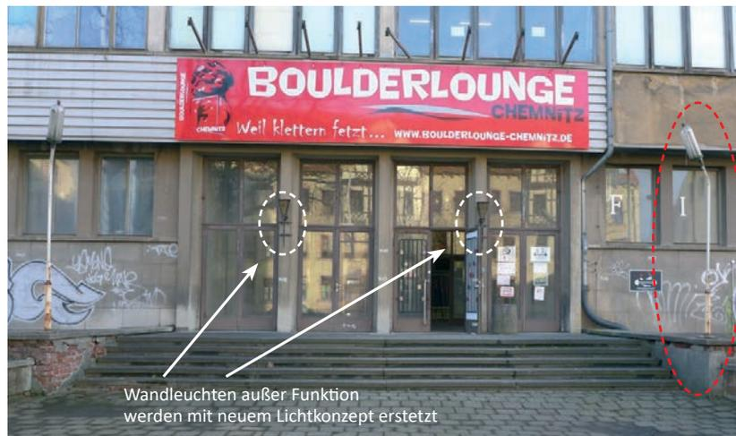
Foto Bestandssituation Fr&uuml;hjahr 2018: dominante Beschilderung nicht mehr relevant (Umzug des Nutzers), Original-Leuchten sind erhalten, aber nicht mehr funktionst&uuml;chtig
