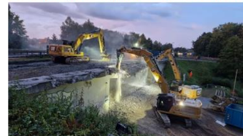
Ersatzneubau von 2 Brückenteilbauwerken mit Fahrspuranpassung unter der Brücke
