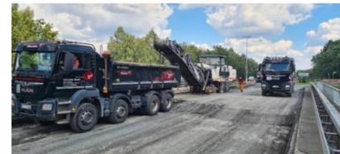
Erneuerung aller Asphaltschichten auf 1200 m Länge, Einsatz von lärminderndem Asphalt
