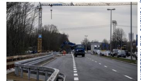
Verlängerung Einfädelsstreifen auf 120 m Länge durch Herstellung einer 100 m langen Stützwand
