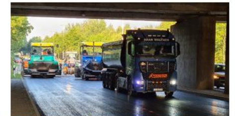
Erneuerung aller Asphaltschichten auf 1200 m Länge, Einsatz von lärminderndem Asphalt
